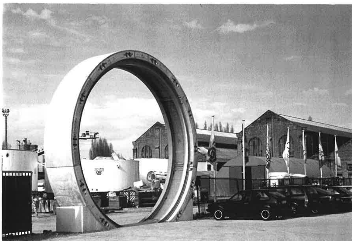
Ci-dessous : Un assemblage de voussoirs simulant une section de tunnel sert de portique d'accès au chantier TUC-RAIL d'Antwerpen-Dam. A l'arrière, d'anciens bâtiments du site aujourd'hui abandonnés par la SNCB. Le 27/02/03 – Photo Guy Bridoux.
